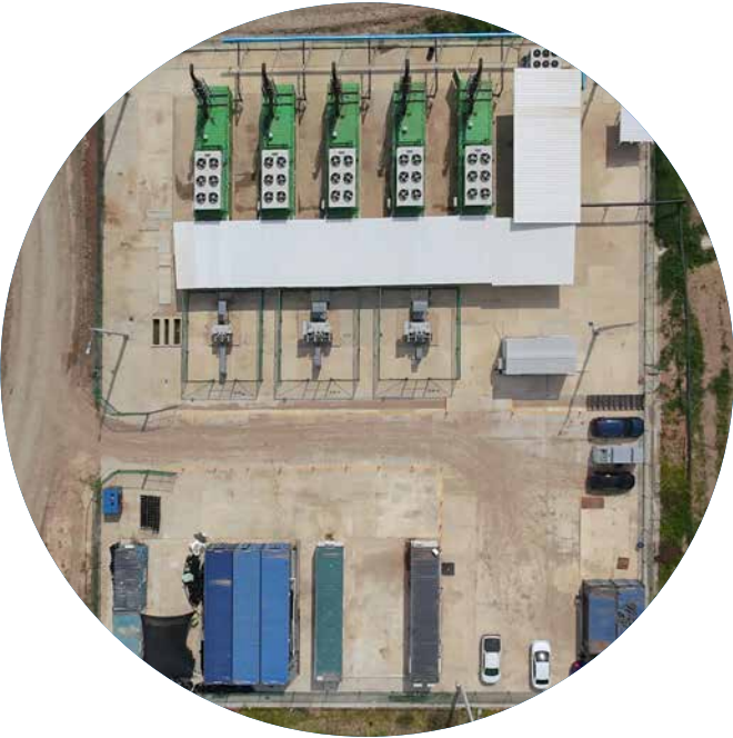
Planta de Biogás
