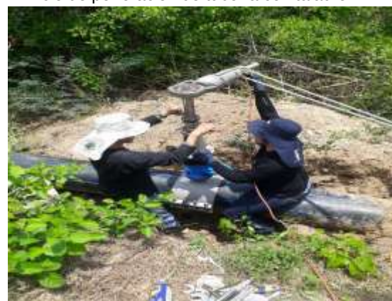
Perforación tubería PEAD 400 mm conducción
