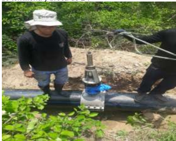
Abriendo válvula de 3" compuerta
