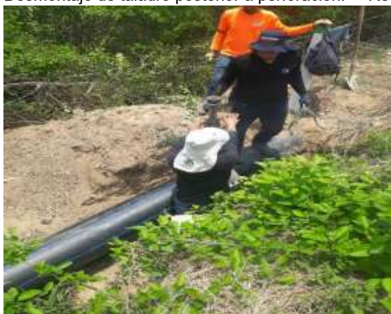
Retiro de broca y cierre de válvula compuerta.
