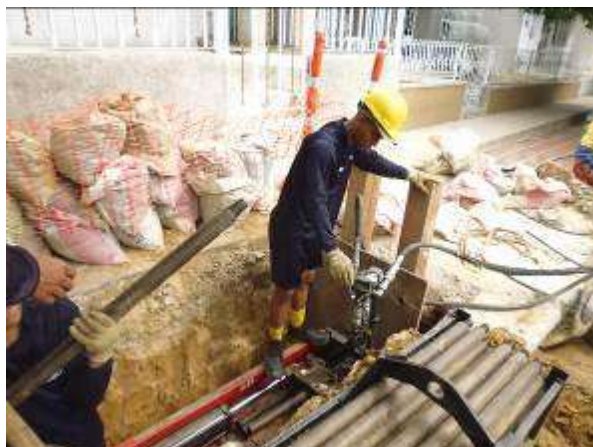
Fotografía 3.4.4.1.14.3 Introducción de las barras
