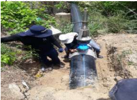
Perforación con taladro diámetro de broca 2".
