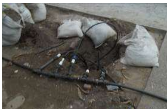
Fotografía 3.4.4.1.14.1 Instalación de by pass
