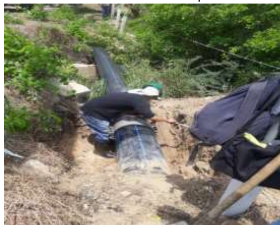
Verificación torque aplicado a tornillos laterales
