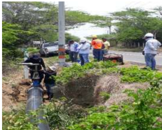
Retiro de tornillería y broca de 2".
