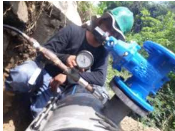
Derivación sometida a 110 PSI de presión.
