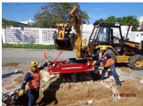
Fotografía 3.4.4.1.14.2 Instalación de la máquina
