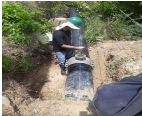
Instalación de tornillería con torquimetro.
