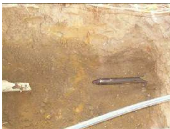
Fotografía 3.4.4.1.14.4. Llegada de las barras de guía
