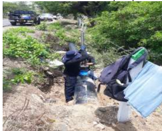
Inicio de perforación de tubería con taladro
