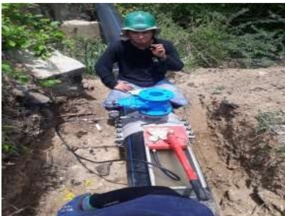
Fijación de taladro con tornillos en brida.
