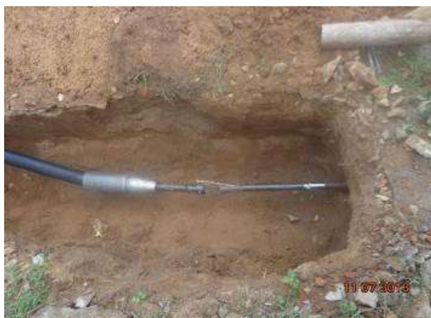
Fotografía 3.4.4.1.14.5 Halado de tubería
