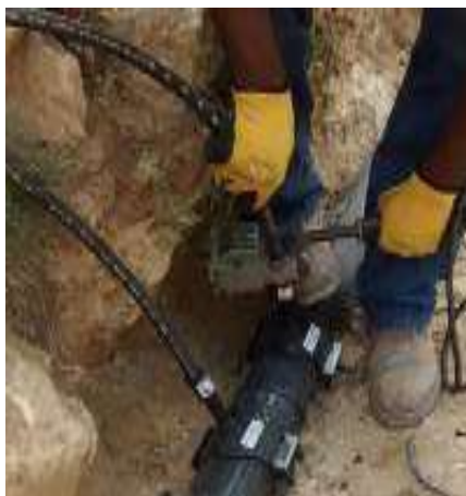
Fotografía 3.4.3.1 Fusión campana encaje
