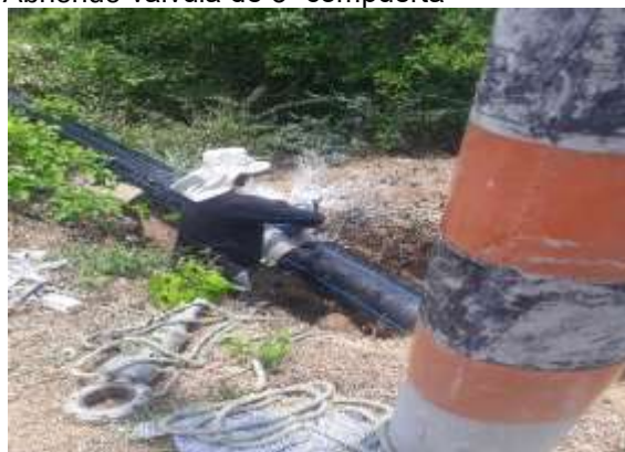
Cierre de válvula – procedimiento finalizado.
