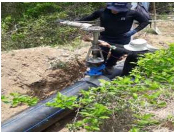
Desmontaje de taladro posterior a perforación.
